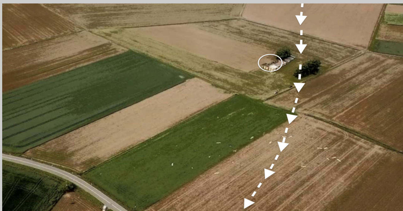
8. Vue drone du hangar de l'ULM club Wissembourg avec environ 50% de la toiture arraché et les débris dispersés dans le sens de déplacement de la tornade. Les tôles les plus éloignées se situent à plus de 420m du hangar ! (photo : Mickael S.C.).
