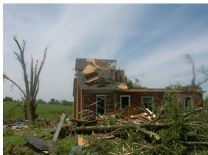
EF2 [176 à 220 km/h] – Dégâts sur la structure porteuse de la toiture (soulèvement ou arrachement de toits), gros arbres déracinés, de nombreux débris légers sont projetés dans les airs sur de longues distances. Des véhicules légers peuvent être déplacés.
