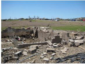
EF5 [ $> 320 \text{ km/h}$ ] – Soulèvement ou désintégration des bâtiments les plus solides (dégâts structuraux très importants sur les immeubles de bureau), les véhicules, camions, trains, arbres, deviennent des projectiles lancés sur de très grandes distances. Dégâts incommensurables et parfois insolites.
